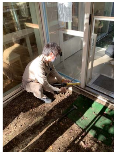
ガラスのシーリング作業
