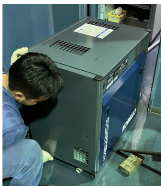
コンプレッサーの搬入作業
